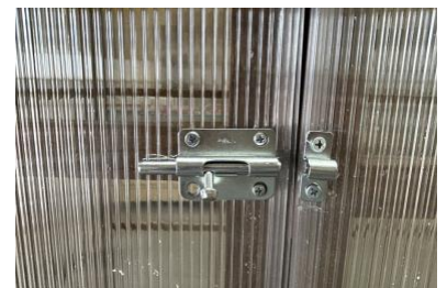
Door Panel: Sliding Bolt Lock
