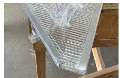
Attach U-Channel: Angled Edge
